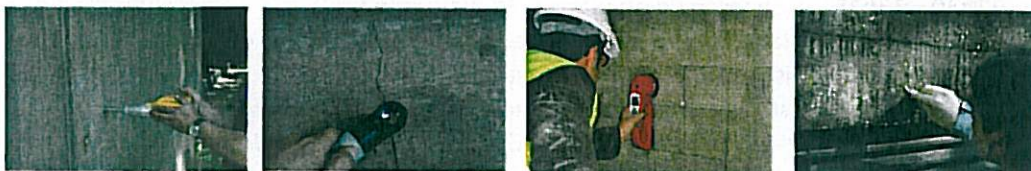
Inspeção e avaliação de estruturas – métodos tradicionais.
