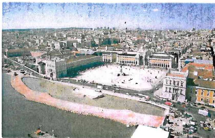
Figura 5 – Aterro executado para a passagem da tuneladora na zona em frente à Praça do Comércio, em Lisboa
