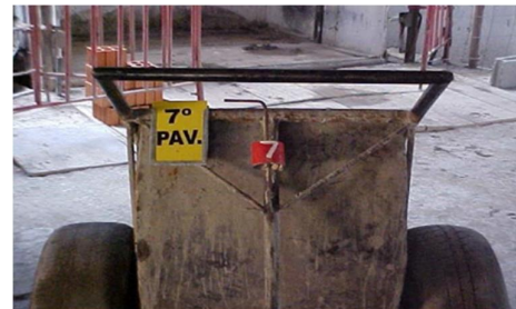
Fig. 5 e 6 - Aplicação na distribuição de argamassa nos diferentes pisos de um edifício com sequência padronizada.
