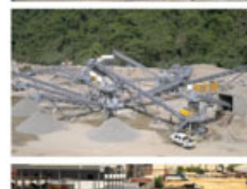
INSTALAÇÃO DE BRITAGEM
